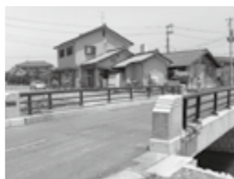
新潟県優良工事▶ P. 8
