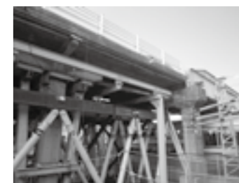
既設跨線橋と仮設トラス桁▶ P.49
